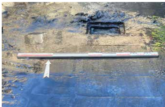
Fig. 13 Detail van de vloer met afvoerputje
