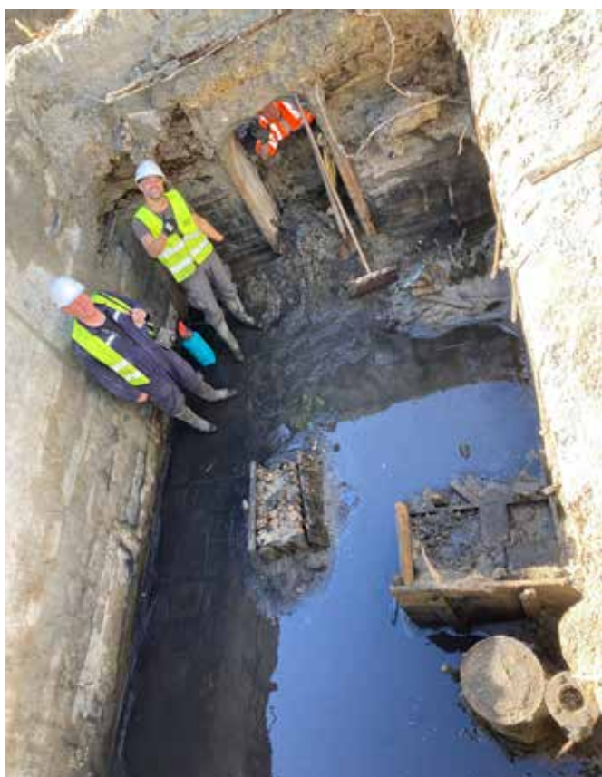
Fig. 17 In kamer 2 van bunker 2 werd een soort tijdsapsule aangetroffen met o.a. kisten conserven, wijnflessen, een kachel met kolenkist en stapels serviesgoed langs de wanden
