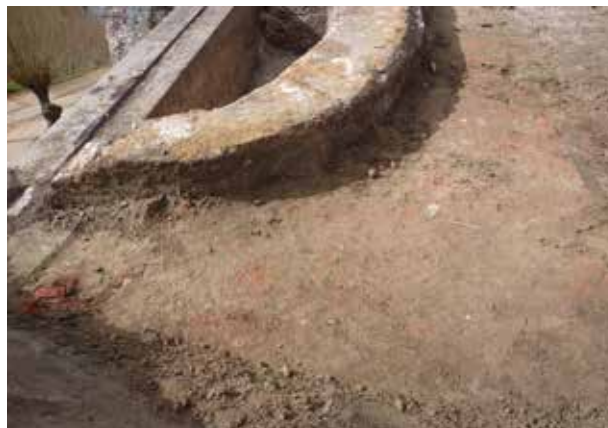
Fig. 17 Restant van een bakstenen vloer achter de teruggetrokken flank. Waarschijnlijk zijn grote delen van het fort oorspronkelijk zo bestraat geweest.
