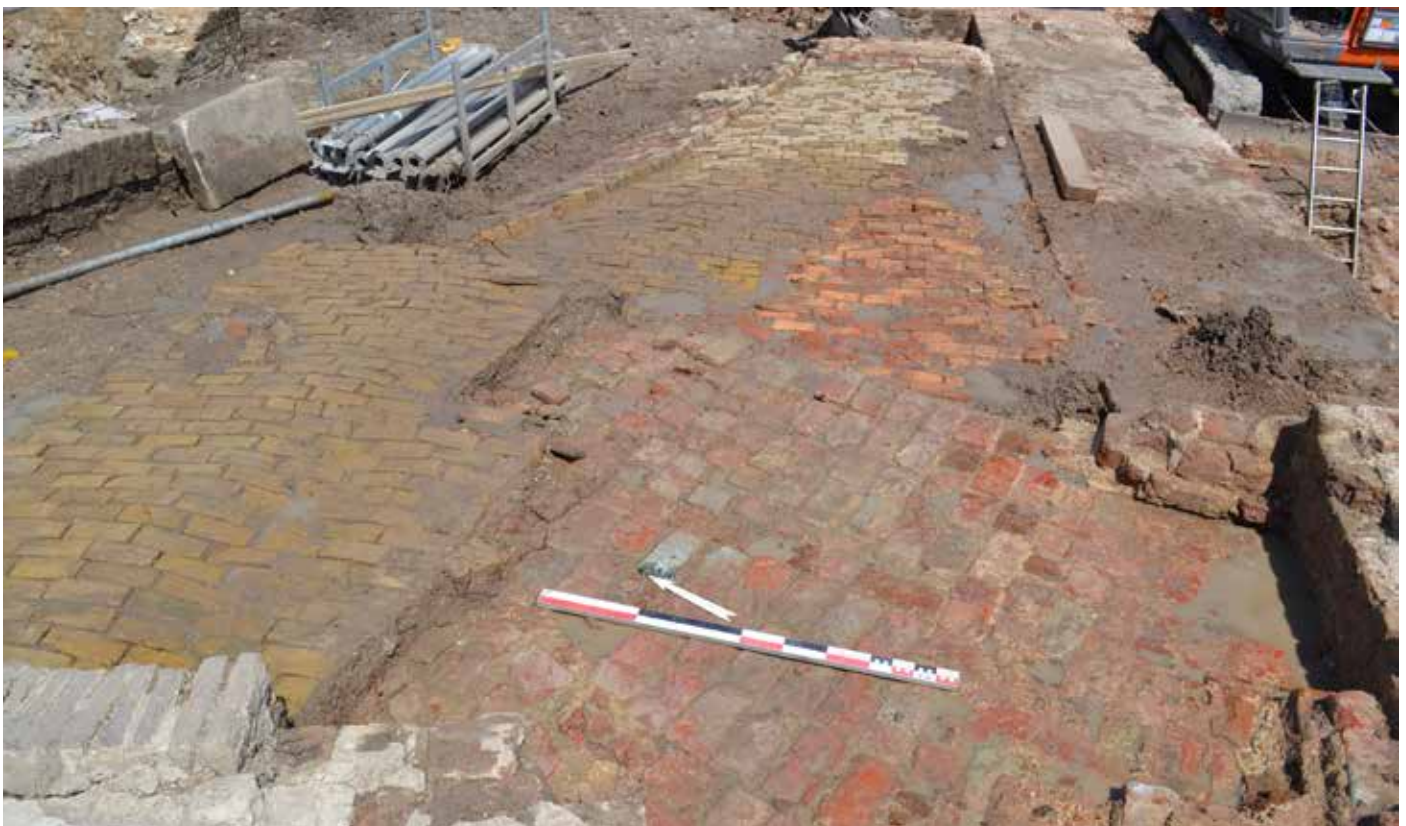
Fig. 21 Verschillende fases van bestrating boven het poortgebouw. Het oostelijke deel dat naast het poortgebouw ligt is verzakt.
