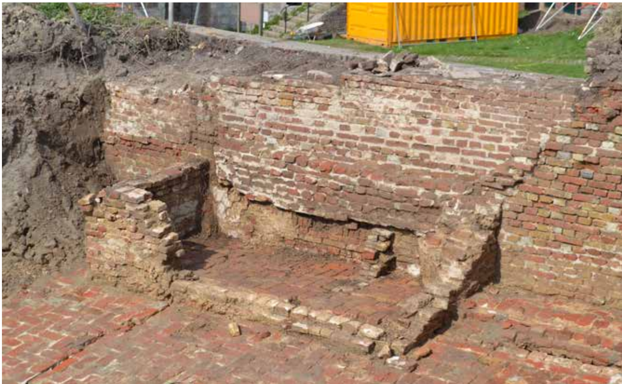
Fig. 53 Het veronderstelde 'wachthuisje' boven de toegang tot de westelijke kazematten. De bovenzijde is gesloopt en de muur is, waarschijnlijk in de Napoleontische tijd, weer opgemetseld
