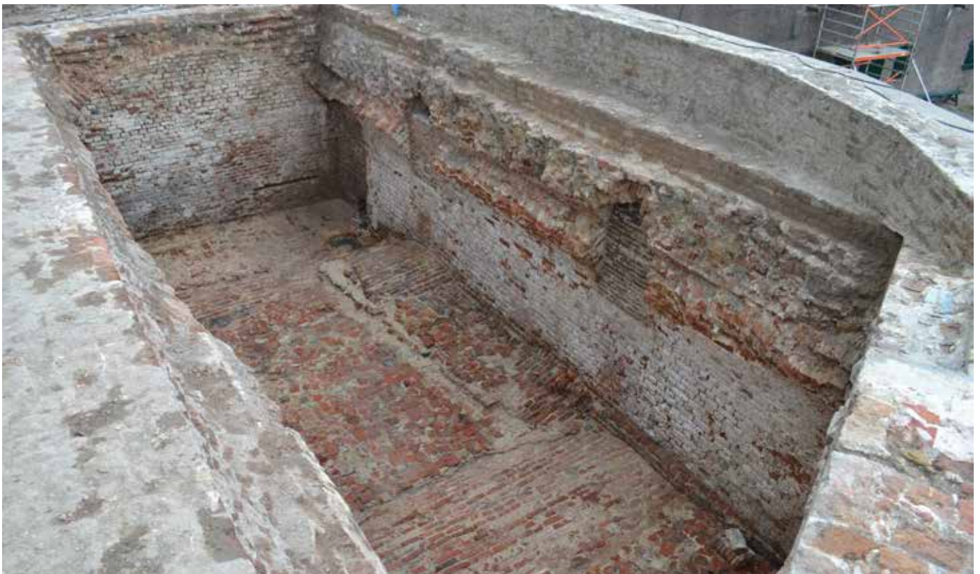
Fig. 24 Zicht op de ontgraven kelderruimte met twee dichtgemetselde ramen en deuropening. De oorspronkelijk houten vloeren zijn voor de sloop van het gebouw in 1811 al verwijderd.
