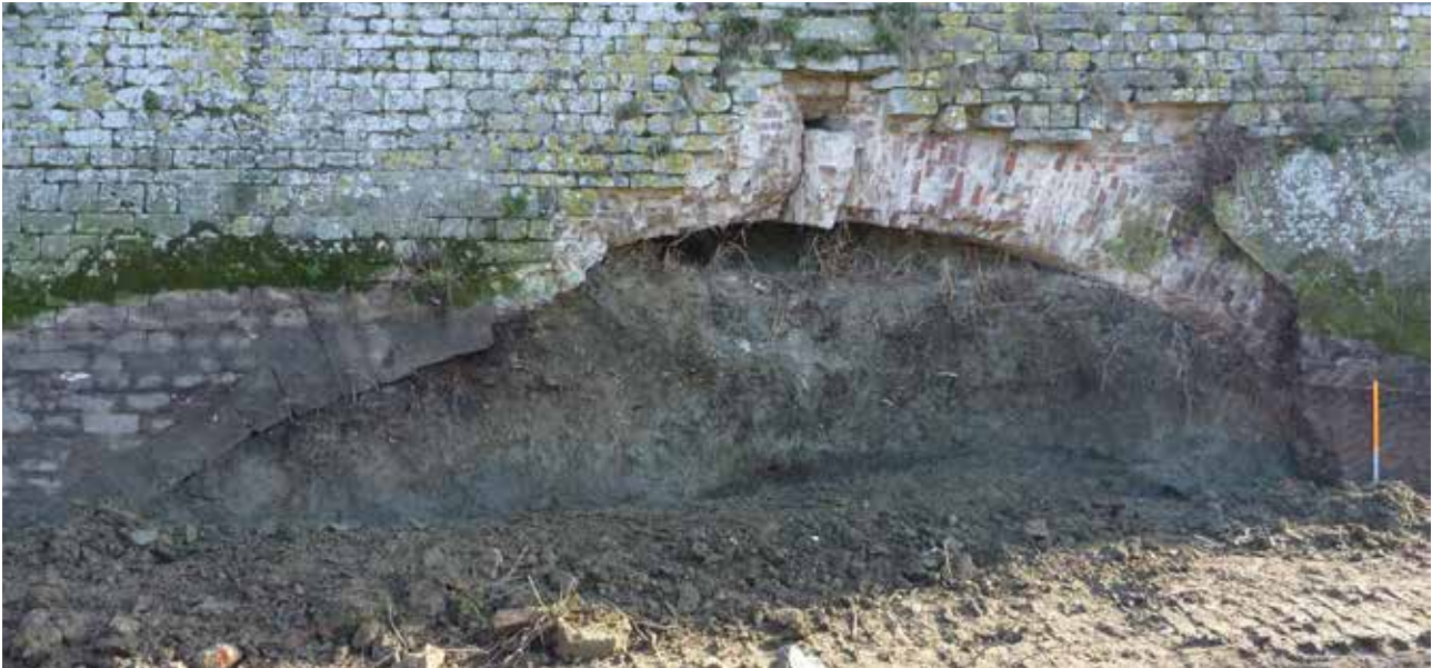
Fig. 73 Overzicht van de westelijke overkluizing van de oude dijk
