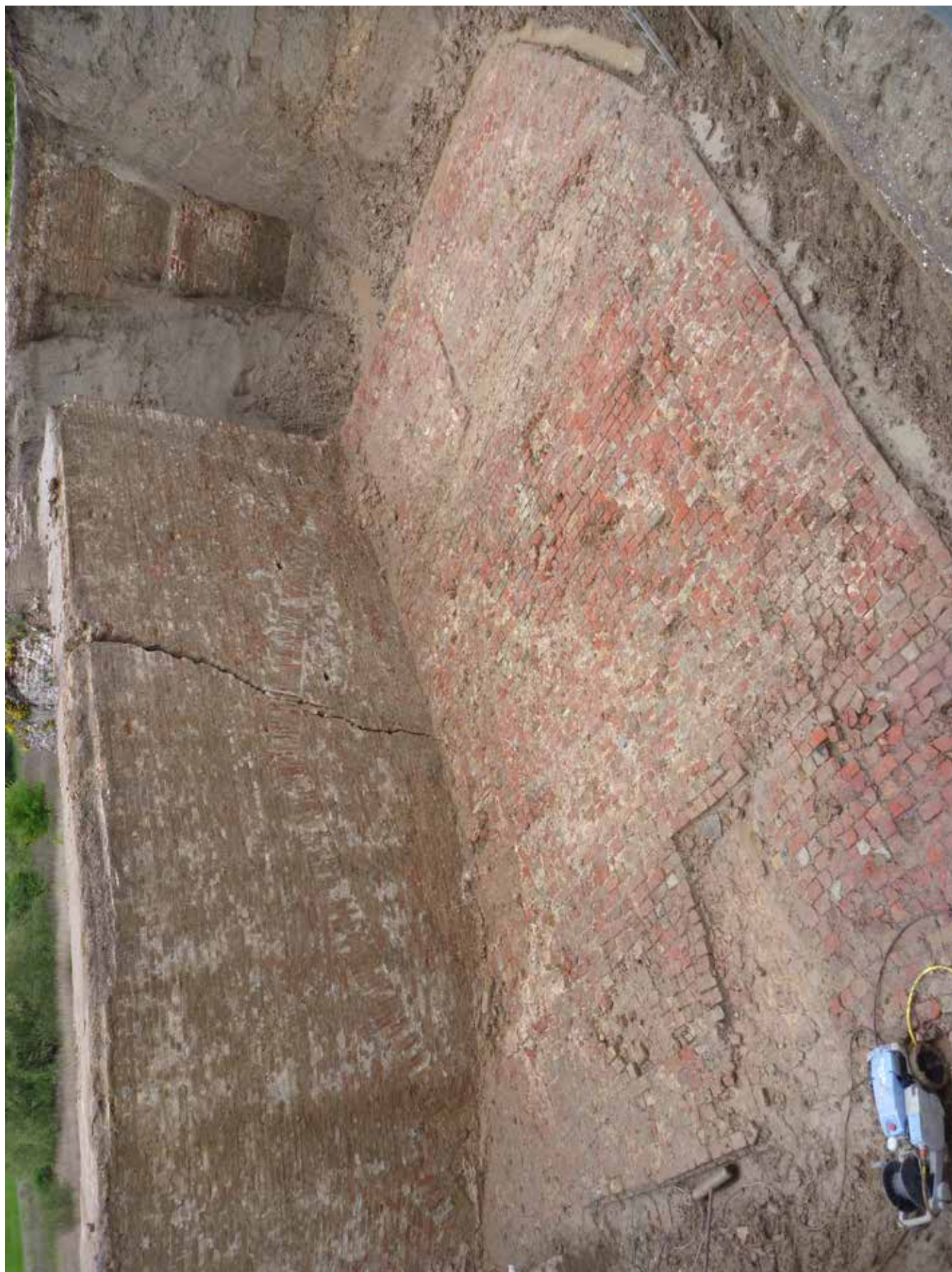
Fig. 19 Zicht op het ontgraven dak van de kazematten en de teruggetrokken flank van het noordoostelijke halfbastion (Zone A)
