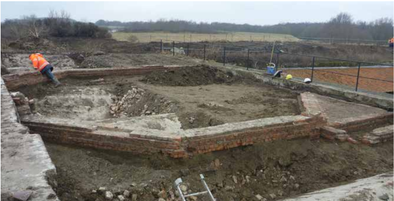
Fig. 48 Constructie uit de tweede Wereldoorlog bovenop de kazematten. De functie is onduidelijk. Na overleg met de RCE heeft deze fundering moeten wijken om de onderliggende kazematten te kunnen bereiken.
