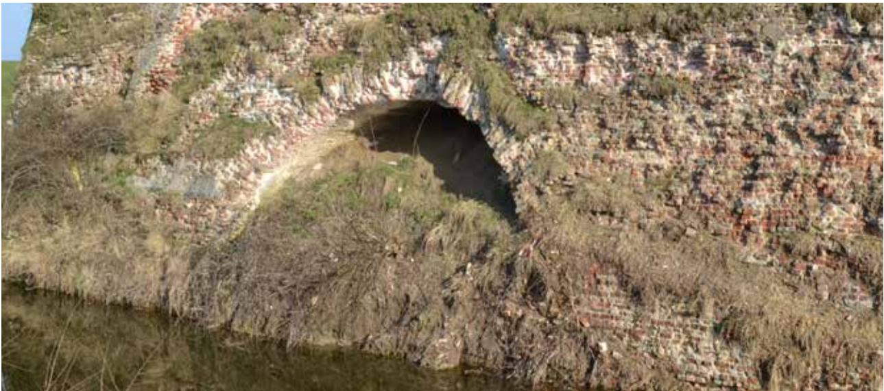
Fig. 78 Overzicht van de oostelijke overkluizing van de oude dijk
