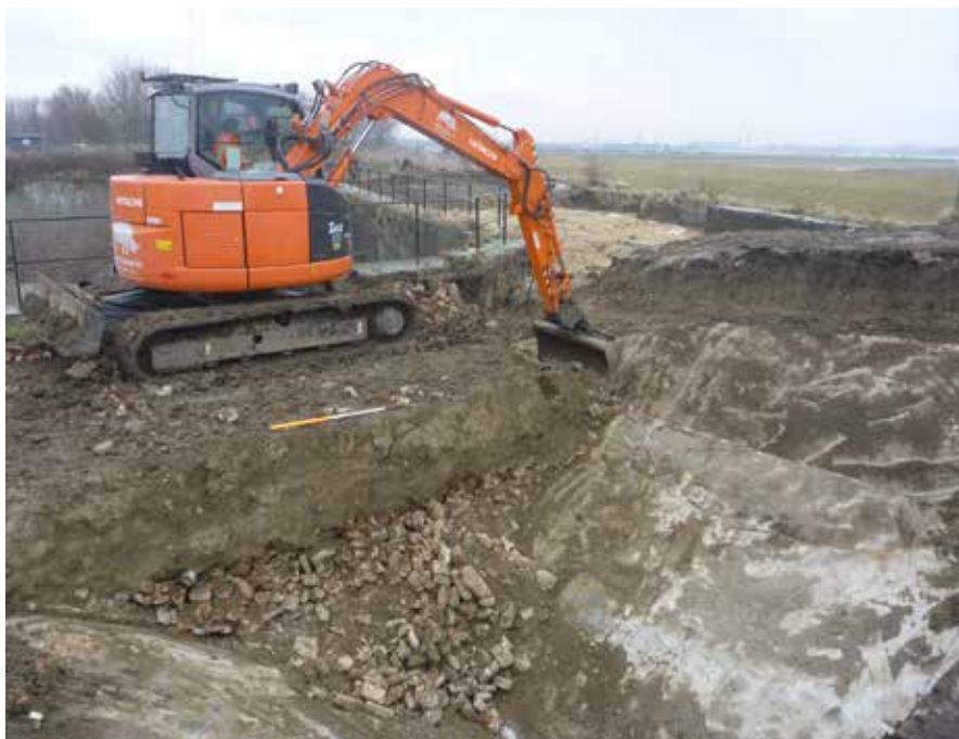
Fig. 47 De Napoleontische kazematten in zone C zijn afgedekt met een puinpakket van losse bakstenen met daarover een zandpakket van ca. één meter. Tussen de punten zijn smalle goten voorzien voor de afwatering.
