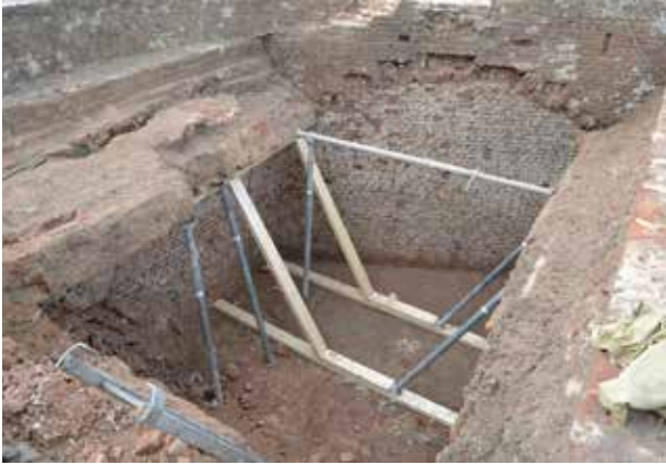
Fig. 23 Een deel van het gewelfde plafond was na ontgraving nog aanwezig maar kon wegens instortingsgevaar niet behouden blijven. Foto: Jan van der Hoeve
