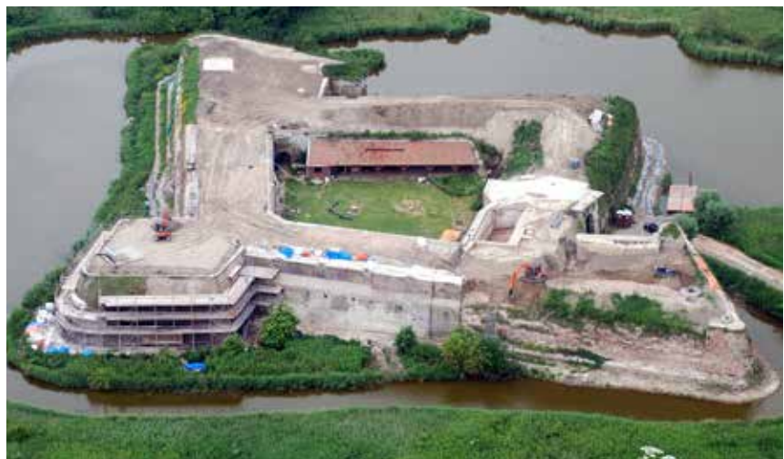
Fig. 11 Luchtfoto fort Rammekens tijdens de consolidatiewerken in 2012. Bron: Staatsbosbeheer
