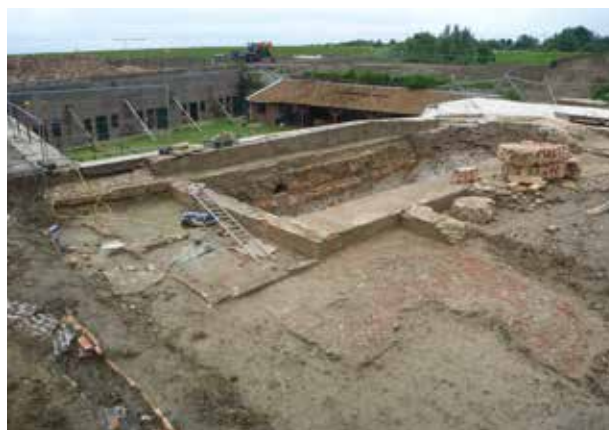
Fig.25 Overzicht op de kelderruimte en de twee aanbouw-tjes. Een bakstenen vloer moest verplaatsingen van mens en materiaal op het fort vergemakkelijken.
