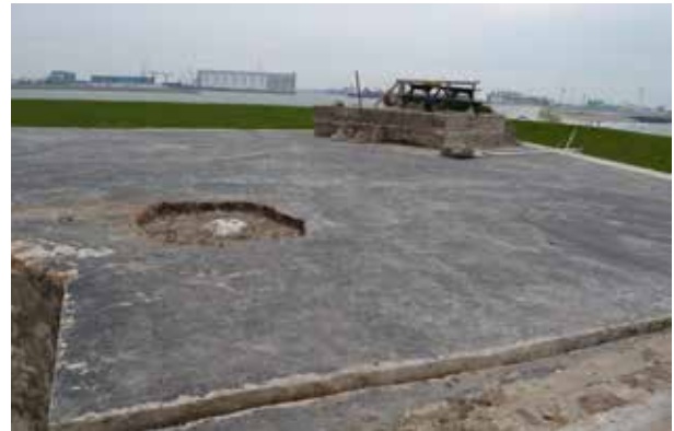
Fig. 46 Het hoofdbastion is afgesmeerd met een zwarte cementlaag waarin rondom een goot is aangebracht. In WOII is een betonnen funderingsvoet door deze afdekking gehakt.
