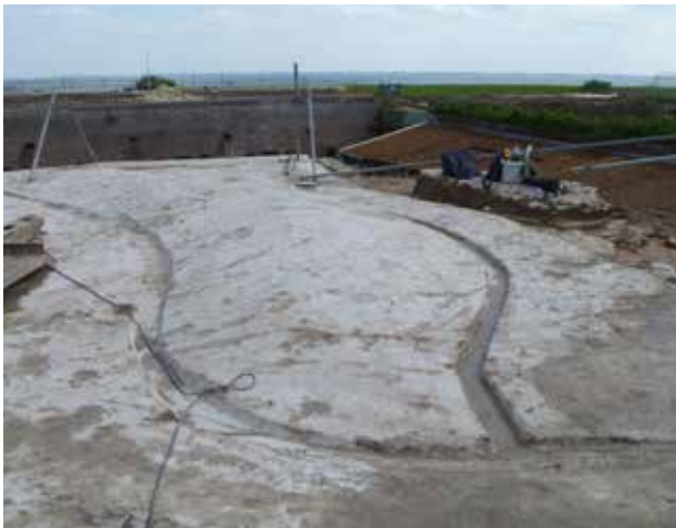
Fig. 27 De 20e-eeuwse herstelwerken boven het poortgebouw. Goten moesten de waterafvoer verzorgen.
