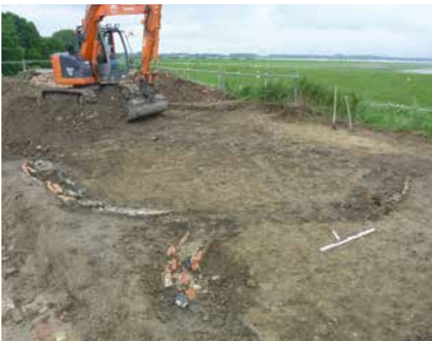
Fig. 33 Bij het aanleggen van de vlakken zijn de loopgraven goed herkenbaar als donkere banen
