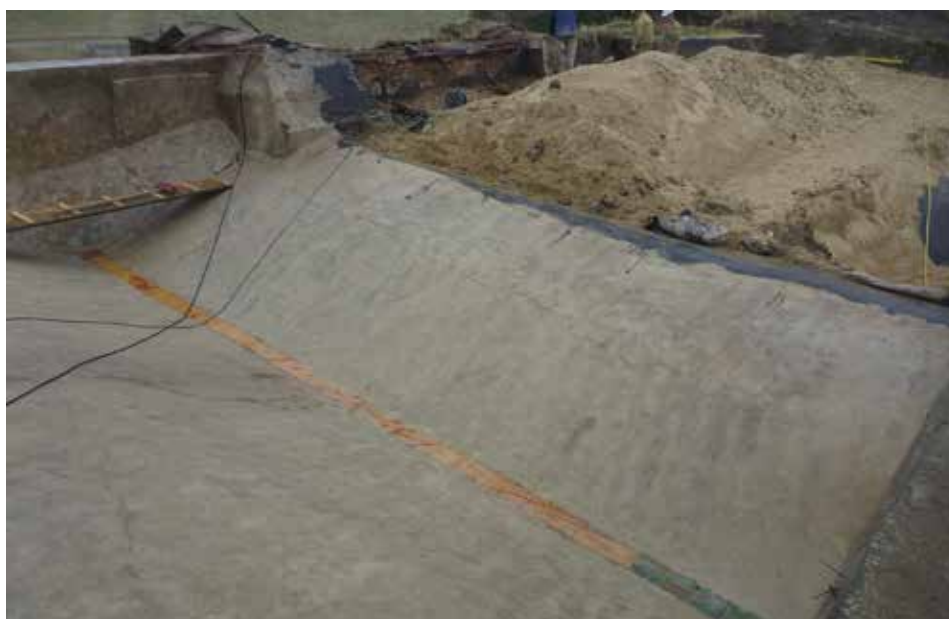
Fig. 45 Overzicht van ontgraven napoleontische kazematten. Centrale meestal betegelde goten voorzien de afwatering. De kazematten worden met behulp van kleine schachten van verse lucht voorzien.
