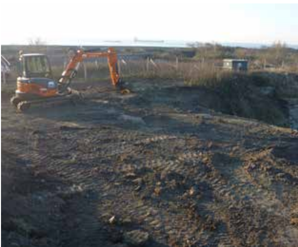
Fig. 16 Overzicht van het afgedekte NO halfbastion voor de start van de werken
