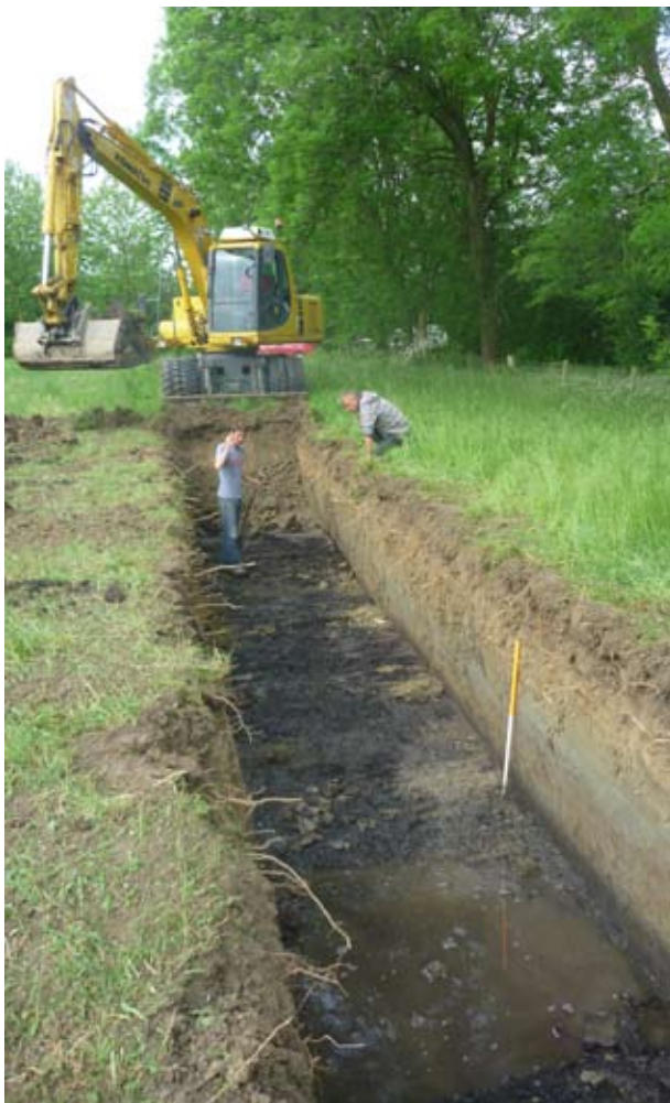
Fig. 11 Aanleg van de proefsleuf op de top van het Hollandveen
