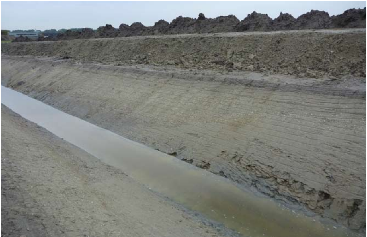
Fig. 11 In het profiel van de sloot in het zuid-westelijke deel van het plangebied is de restgeul, met zand en schelpresten, nog goed herkenbaar
