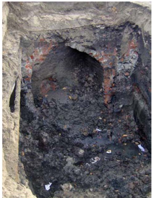
Fig. 5 Beerbak, aangetroffen bij de aanleg van een huisvuilcontainer op de Bodenplaats. Resten van het voormalige klooster bevinden zich tussen 50 en 300 cm -MV.
