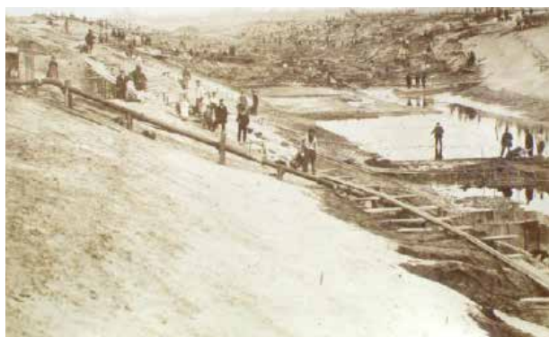
Fig. 13 Manuele aanleg van het kanaal door Walcheren rond 1869 [ZI-III-0326.14]
