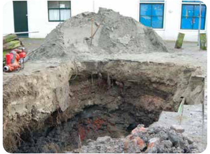
zuidprofiel (riool en stadsmuur)
