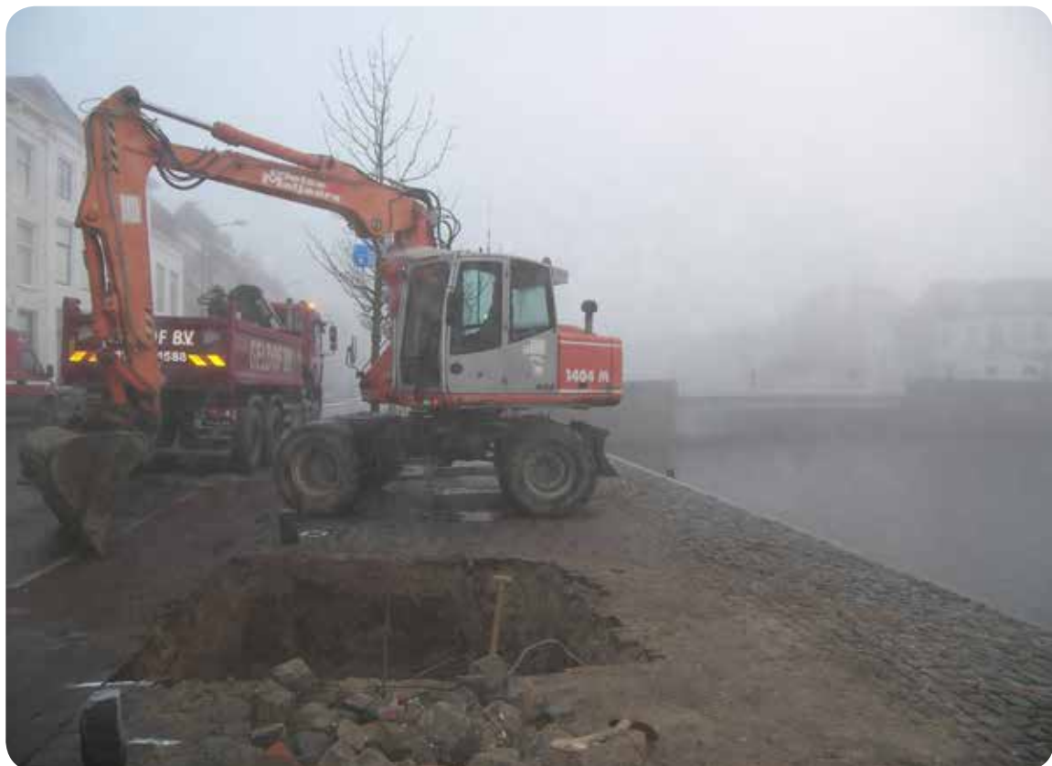
graven van de container aan de Houtkaai
