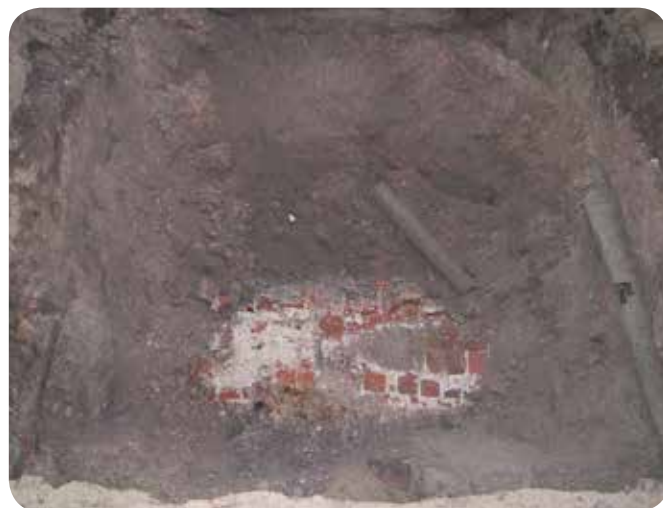
detail zware muur (bovenzijde op ca. 170 cm -MV)
