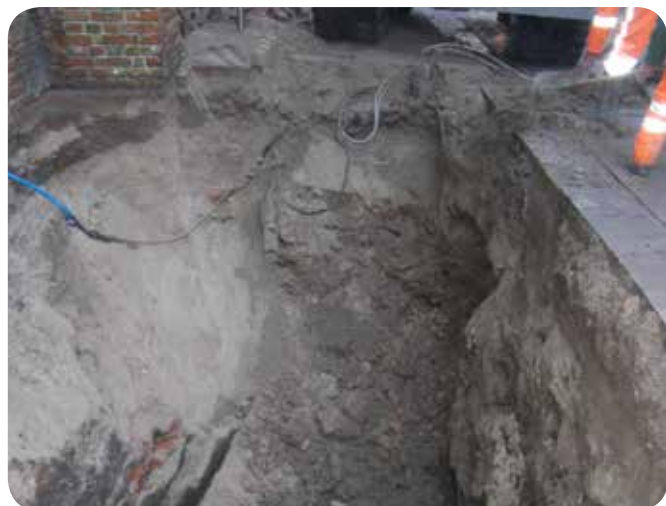
westprofiel (kelder huisjes)
