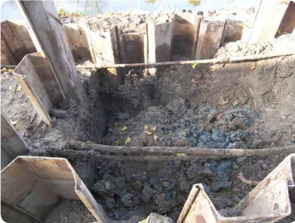
vlak; de zichtbaarheid door de damwanden was zeer beperkt
