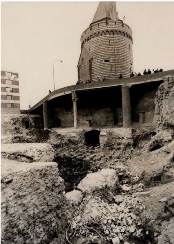
Fig. 27 Funderingen van de bomvrije kazerne, aangetroffen bij de nieuwbouwwerken aan de Boulevard.
