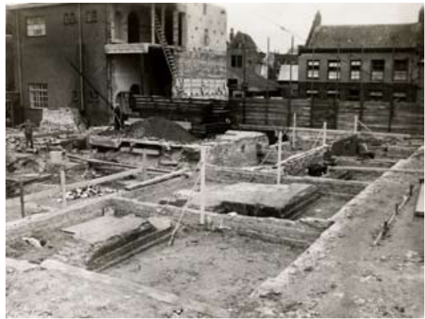
Fig. 25 Funderingen van het oude stadhuis op een foto uit 1948, aangetroffen bij de bouw van de school op de Markt.
